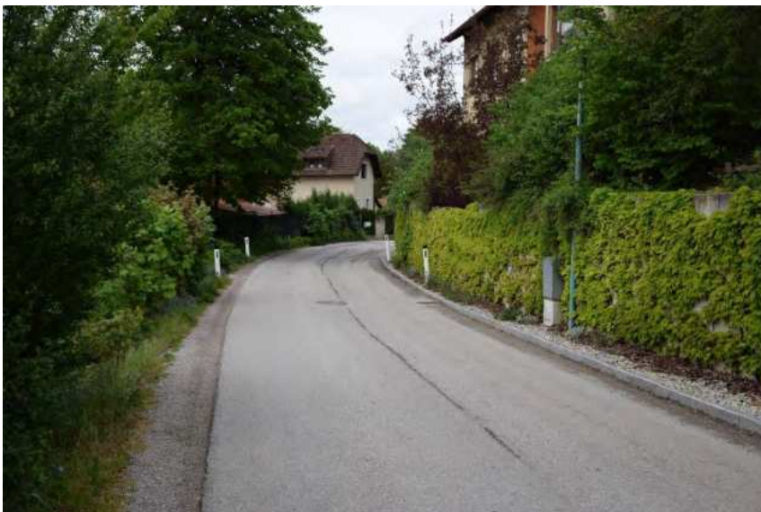
Abbildung 39: 50er-Zone und fehlende Gehwege in der Austraße trotz schmaler Zweirichtungsfahrbahn; Eigenes Foto; Aufnahmedatum 12.05.2021
